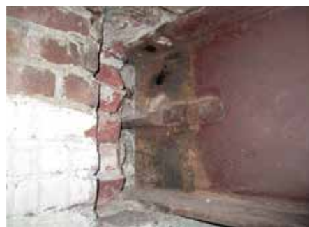
De stalen liggers zijn bij de oplegging in het metselwerk gecontroleerd op corrosie.
