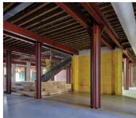
Begane grond met oude Hennebique-betonwanden.
