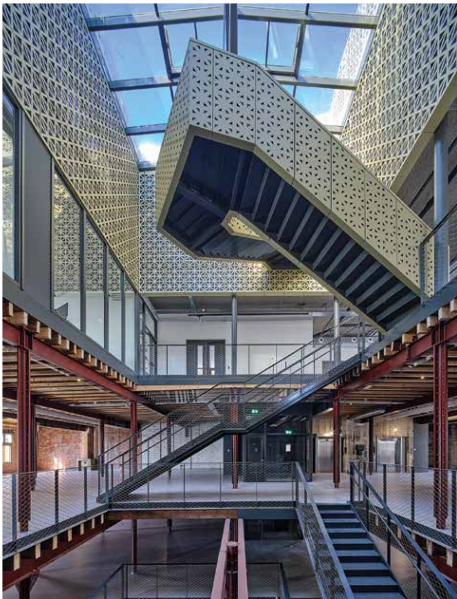
In de optop een nieuwe trap die oud en nieuw verbindt.
