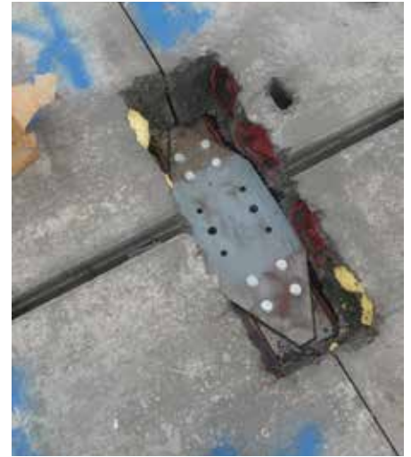
...zijn er extra gaten gefreesd en pasbouten toegepast.
