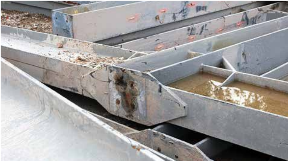
De bestaande lussen komen ook niet overeen met de architecttekeningen. Na onderzoek...
