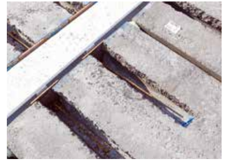
De stekken worden achteraf aangegoten met beton.
