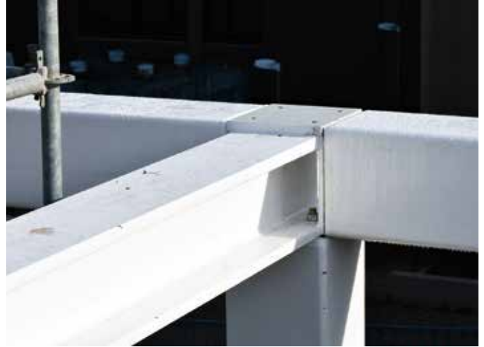
Alle verbindingen zijn bereikbaar.
