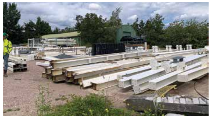
9. Derde inspectie in hub.
