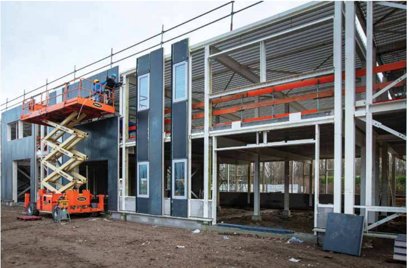
Door hoge bouw fysieke eisen aan het TNO EMB Lab destijds, voldoen de hergebruikte sandwichpanelen zonder meer aan de huidige eisen.
