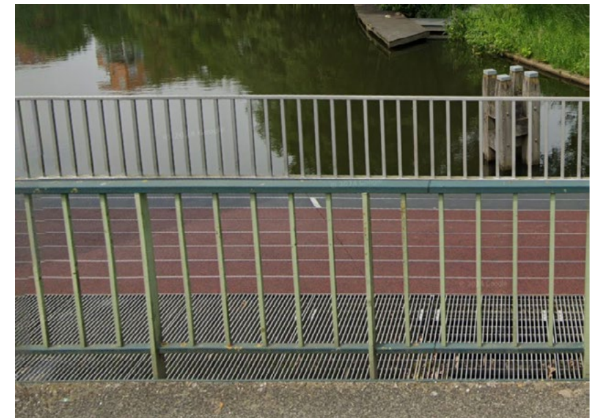
EPDM slijtlaag fietsbrug Welgelegen brug Apeldoorn
